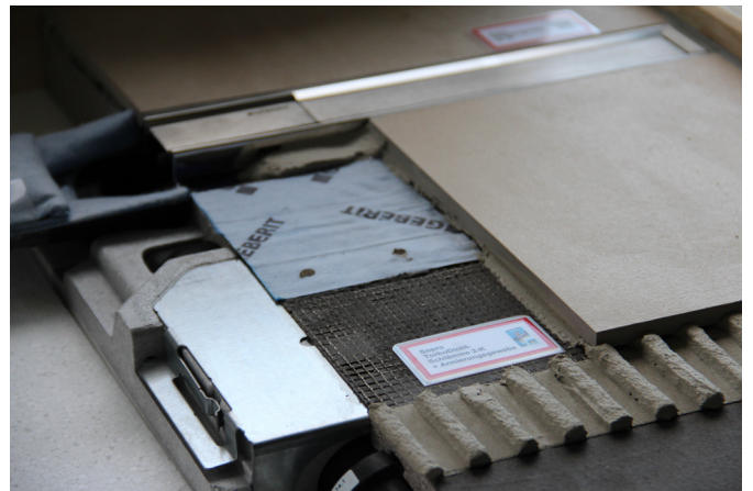
Abbildung 57: Beispiel Geberit CleanLine Grundkörper ohne Estrichüberdeckung mit Materialien der Sopro Bauchemie GmbH.
