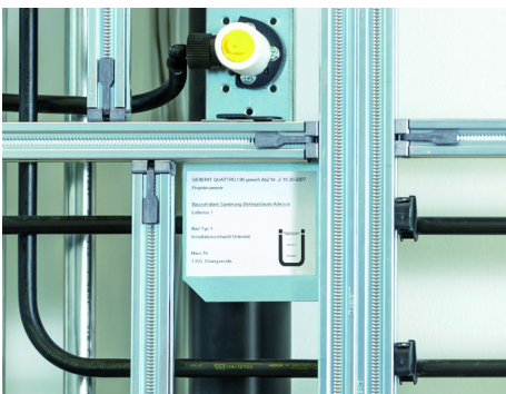
Abbildung 31: Die Einheiten werden mit Ü-Kennzeichnung ausgeliefert
