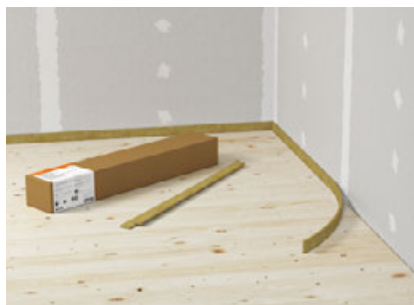
Randdämmstreifen verlegen und in den Ecken stumpf stoßen
