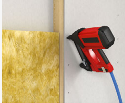
Klammern auf Holzunterkonstruktion
