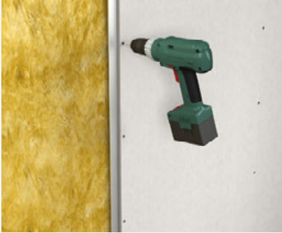
Schrauben auf Metallunterkonstruktion
