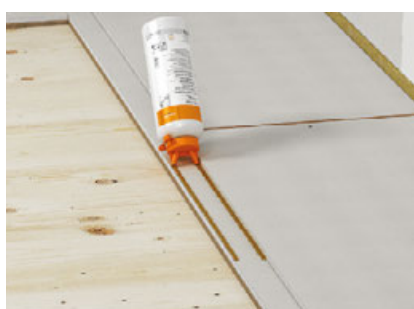
Auftragen des fermacell™ Estrich-Klebers im Falzbereich
