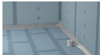
Geeignete Verbundabdichtung in den Anschlussbereichen auftragen und systemkonformes Dichtband eindrücken.
