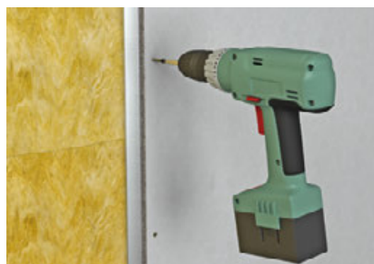
Die Platten mit fermacell™ Powerpanel H 2 O Schnellbauschrauben im Abstand von 20 cm auf der Unterkonstruktion befestigen.
