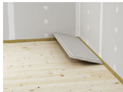
Verlegen der fermacell® Estrich-Elemente
