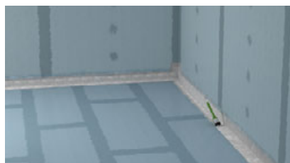
Dichtband direkt nach dem Eindrücken mit dem Abdichtungsmaterial überarbeiten.
