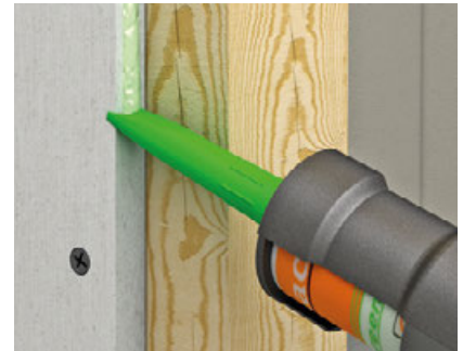
fermacell™ Fugenkleber auf die senkrechten bzw. waagerechten Plattenkanten auftragen.
