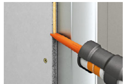
fermacell™ Fugenkleber auf die Plattenkanten auftragen und weiter beplanken.
