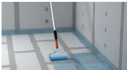
Systemkonformen Tiefengrund nach Herstellervorgaben im angrenzenden Wandbereich und Bodenbereich per Rolle auftragen.
