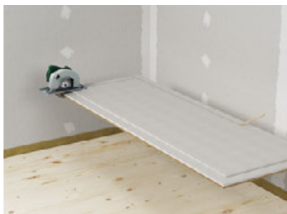
Absägen des überstehenden Falzes für die erste Verlegereihe
