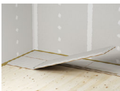
Verkleben der Elemente mit vollständig gefüllten Fugen
