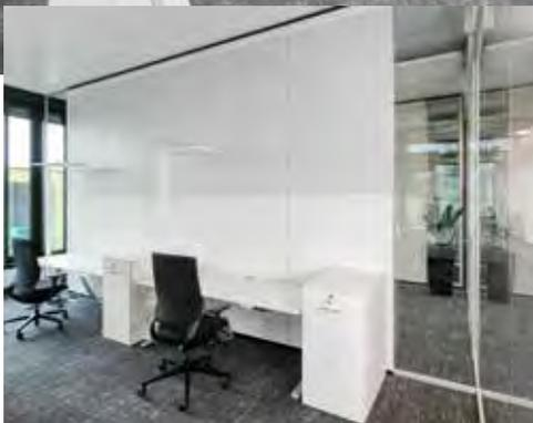
Da das Gebäude mit einer bauteil-aktivierten Betondecke konzipiert ist, tragen wandintegrierte Absorber zur Reduzierung der Nachhallzeiten bei.
