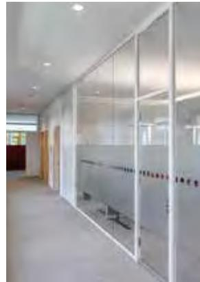
Bei einer Wandhöhe von 3,85 m wurde die Glastür raumhoch mit integriertem Glasoberlicht und Querkämpfer ausgeführt.
