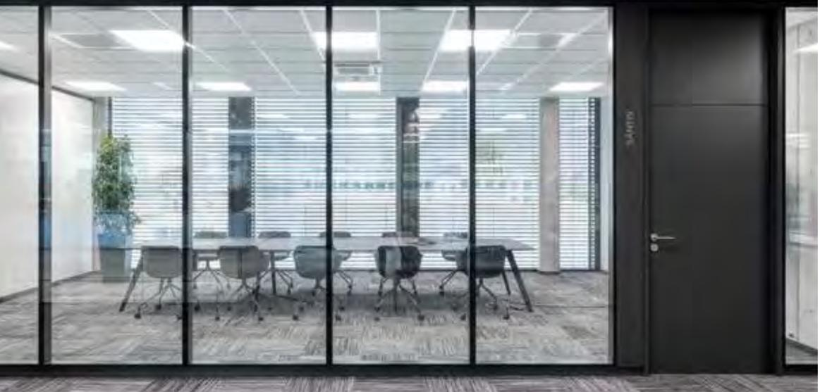
Der Neubau in Wangen mit verschiedenen Gebäudeteilen für Büroräume, Labore, Lager, Montagefläche und Fertigung ermöglicht ein teamorientiertes Arbeiten. feco hat mit der Nurglaskonstruktion fecoplan mit 16 mm VSG und einem Schalldämmprüfwert von  $R_{w,P} = 40$  bzw. 42 dB eine transparente Arbeitsumgebung geschaffen. In Besprechungsräumen und in den Büros der Geschäftsleitung erfüllt die Strucural-Glazing-Verglasung fecostruct mit  $R_{w,P} = 47$  dB noch höhere Schalldämmanforderungen.
