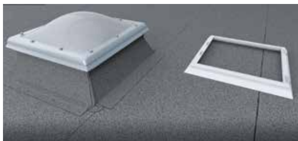
Demontage des alten Oberlichts und der Scharniere
