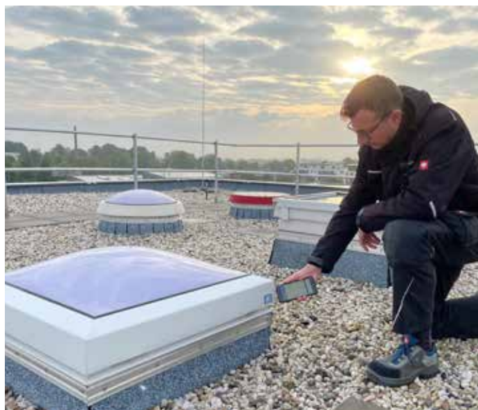
Zum Auslesen reicht es, ein NFC-fähiges Smartphone in die Nähe des Aufklebers mit dem Chip zu halten. Als Alternative zum Chip ist ein QR-Code aufgedruckt.
