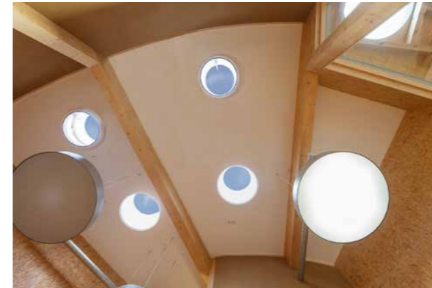
Naturkindertagesstätte „Wildblume“, Garz Lichtkuppel essertop® eckig und rund Rauch- und Wärmeabzug fumilux® 4000 EAZ
