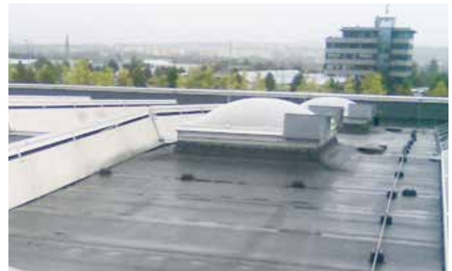
Rauchabzüge sind oftmals erkennbar an Windleitwänden bzw. Eckspoilern.
