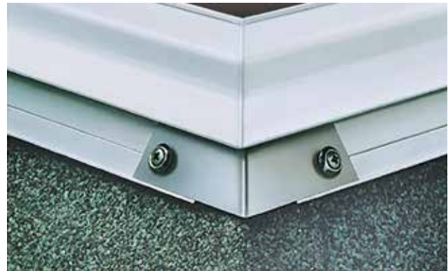
Mechanische Fixierung der Dachbahn am Aufsetzkranz.
