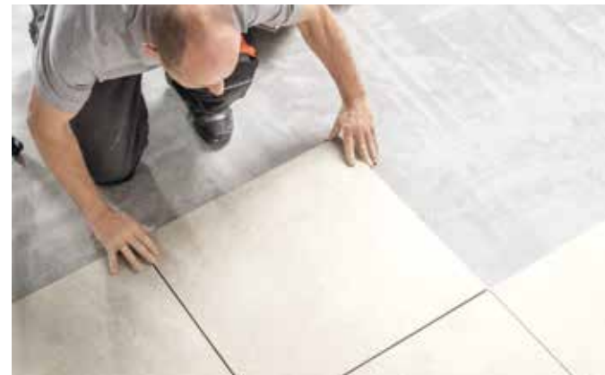
3 Fugenraster festlegen und Korkkanten press aneinander legen.
