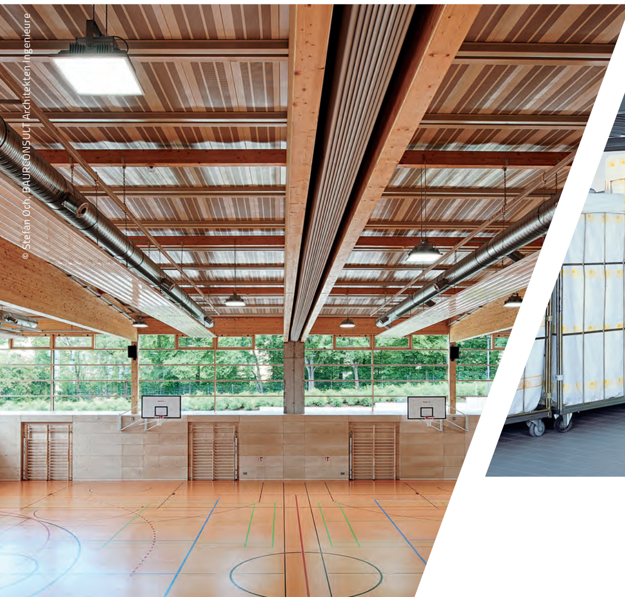
SPORTHALLE Element-Dach Akustikausführung mit perforierten Kassetten
