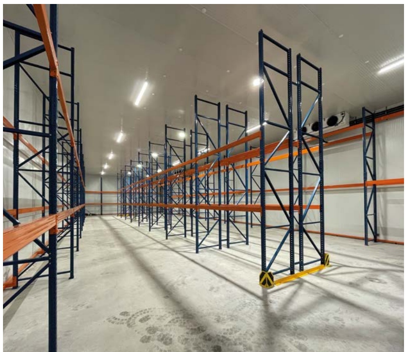
Das Lager dient zur Tiefkühlung von Fisch und Meeresfrüchten.
