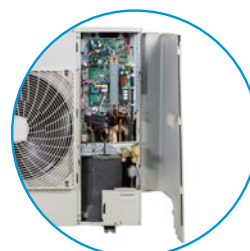
Schwenkbare Frontplatte für einfachen Zugang zu wichtigen Systemkomponenten
