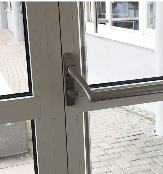
CES OMEGA FLEX Anti-Panik-Zylinder an einer Paniktür
