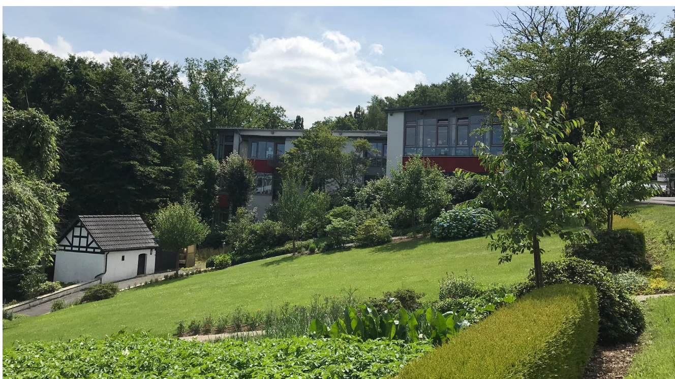
Die Grundschule im Schulzentrum Nümbrecht
