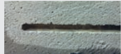
Selbst bei waagerechter Bohrung läuft kein Material aus dem Bohrloch und kann sich gleichmäßig im Mauerwerk verteilen.
