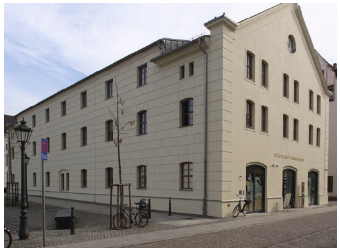
Artilleriewagenhaus in Wittenberg nach der Fassadensanierung
