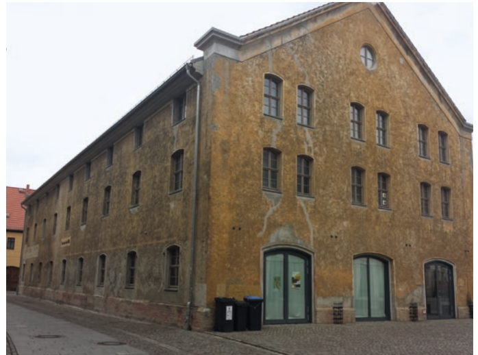
Artilleriewagenhaus in Wittenberg vor der Fassadensanierung
