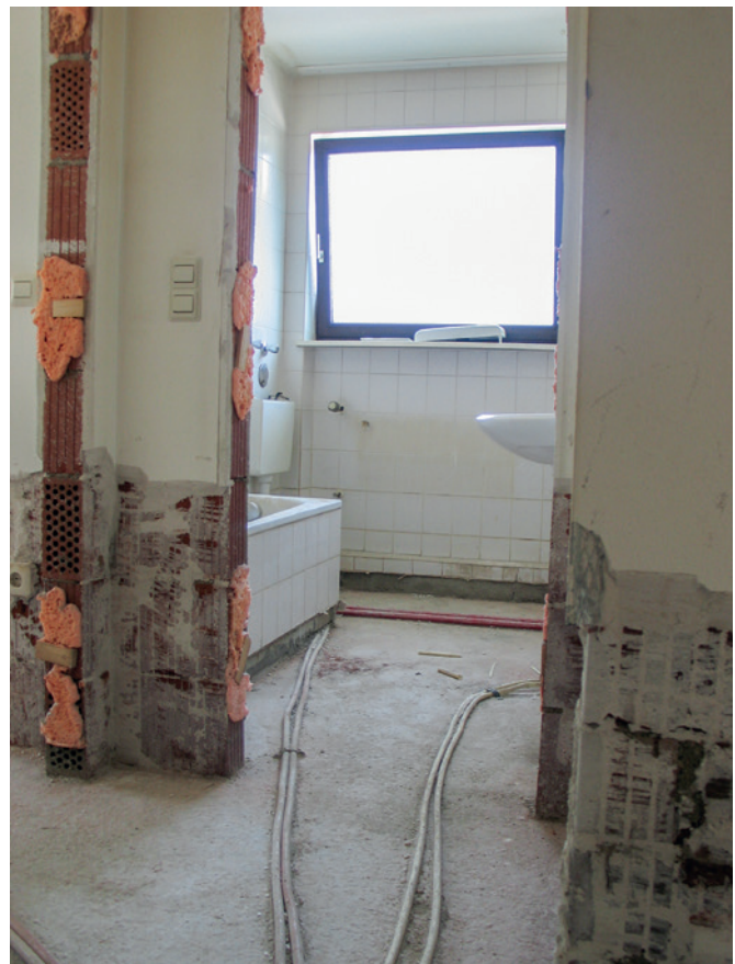
Situation nach Estrichausbau
