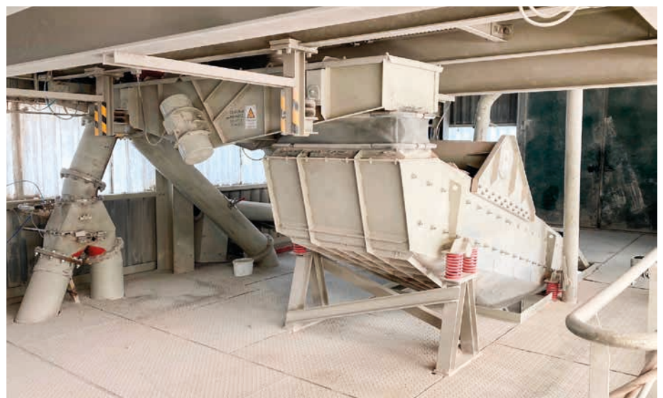
Ein Teil unserer modernen Anlagen für eine Kreislaufwirtschaft mit recyklierten Gesteinskörnungen.
