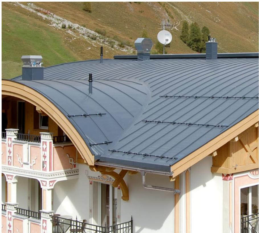
**Produktbeschreibung:** Das EVALON®-Strukturprofil ist ein extrudiertes Hohlkammerprofil.
