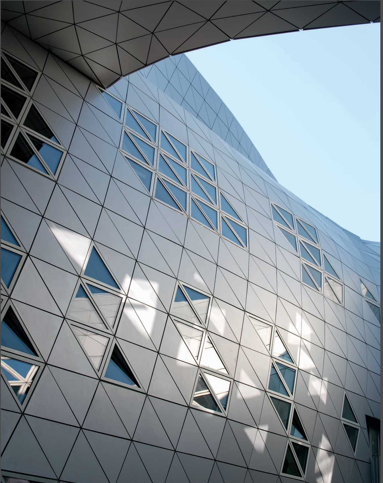
Lycée Georges Frêche, Frankreich | Architekt: Massimiliano und Doriana Fuksas, Rom, Paris | Verarbeiter: Tim Composites, SMAC Toulouse Material: ALUCOBOND® anodized look C0/EV1 | Fotos: © Moreno Maggi
